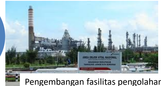
Pembangunan PLTU Tanjung Jati B 2x1000MW di Jepara, Jawa Tengah oleh konsorsium Shimizu-IHI-Hyundai Engineering and Construction dengan nilai kontrak $1,9 miliar.
